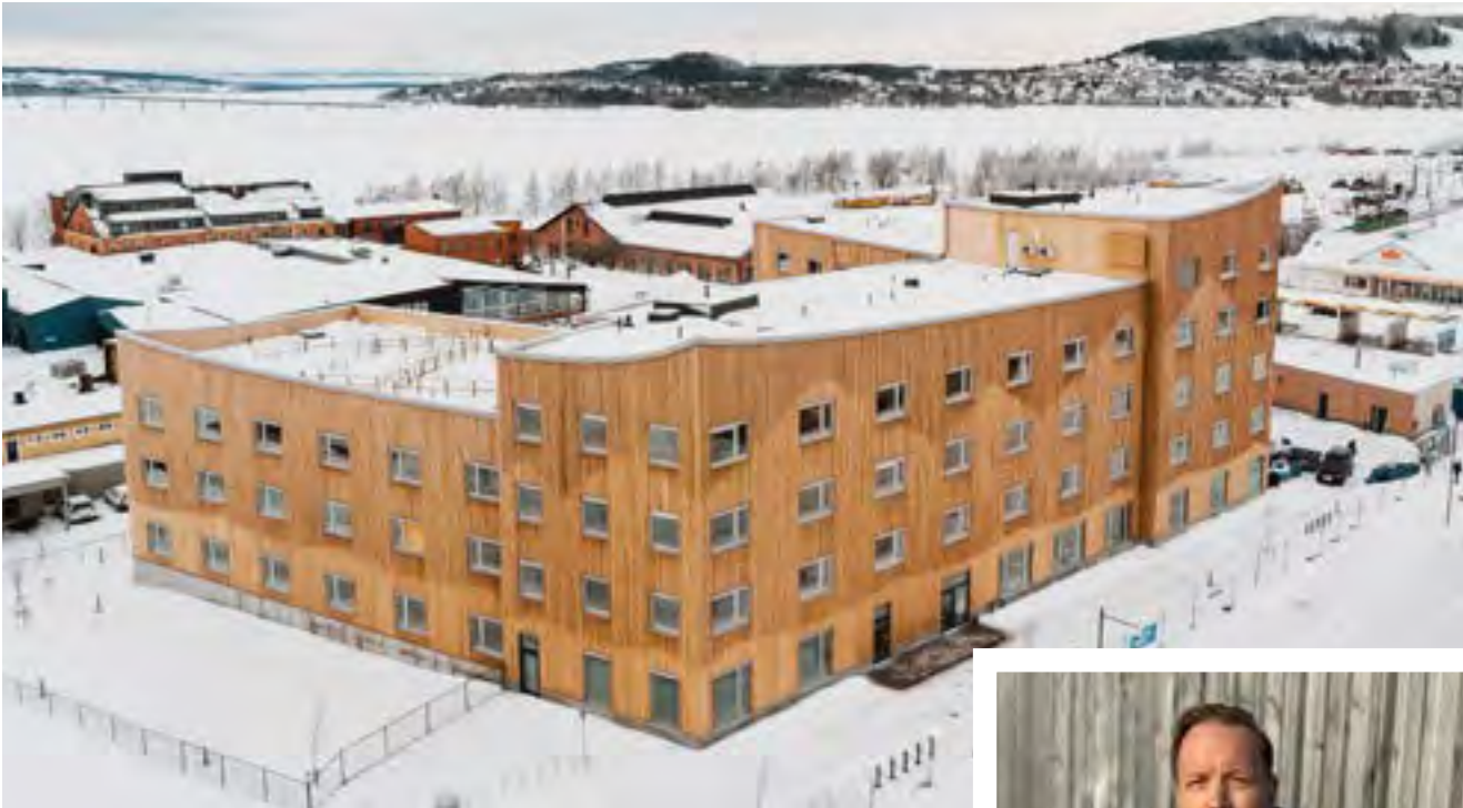
Projektet Norrsken i Östersund. På takterrassen har de boende utsikt över Storsjön med Jämtlandsfjällen som fond.
