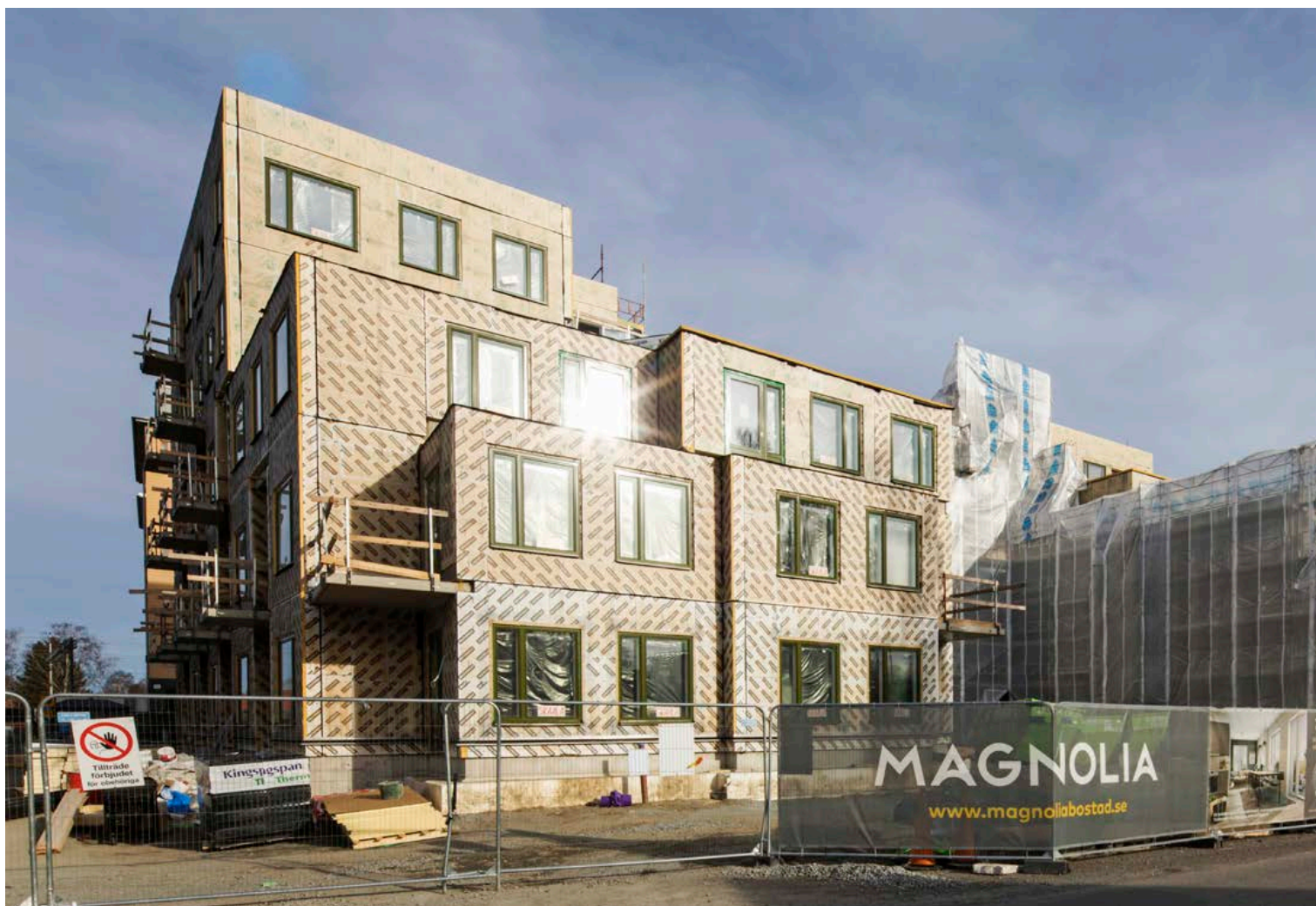
På Turebergs Allé, mellan Stinsen köcentrum och Sollentuna Centrum, uppför Magnolia Bostad för närvarande 90 bostadsrätter i projektet Lumen. Byggnation inleddes under 2015 och inflyttning är planerad att ske under 2017.
